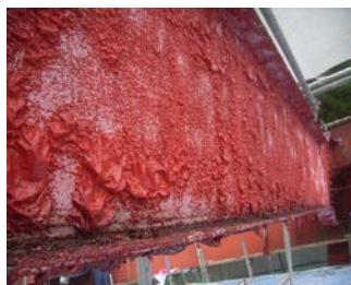
塗膜剥離剤処理
