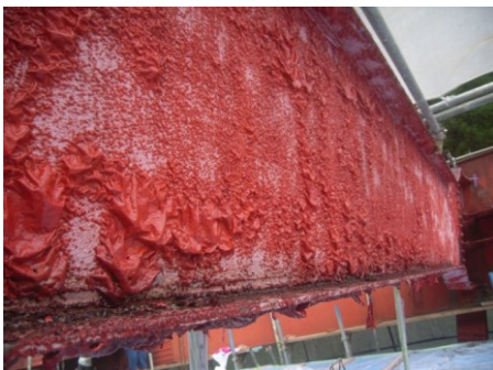
塗膜剥離剤処理
