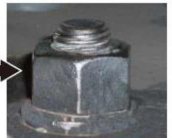
ボルト部施工後
