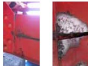
高知県土木部 四万十川橋／試験施工
