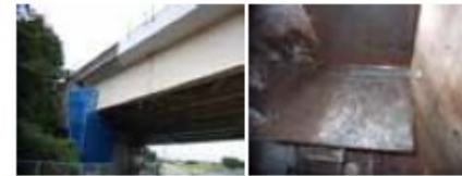
中日本高速道路(株) 堀坂川橋／試験施工
