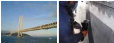
本州四国連絡橋高速道路(株) 明石海峡大橋／試験施工
