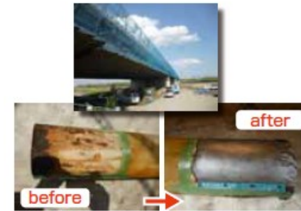
中日本高速道路(株) 揖斐川橋／試験施工
