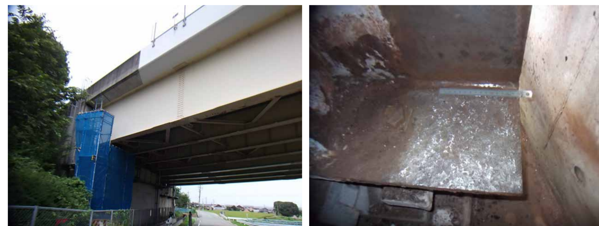
中日本高速道路(株) 堀坂川橋 / 試験施工
