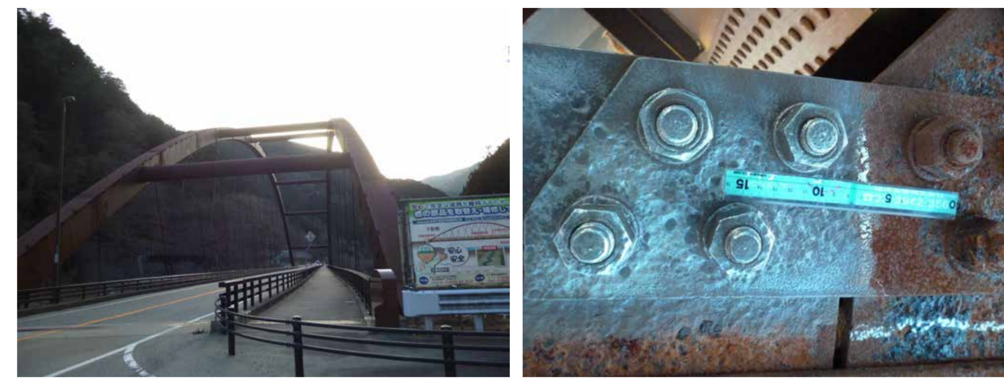
国交省高山国道事務所 不動橋 / 試験施工
