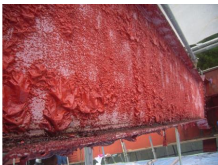
塗膜剥離剤処理
