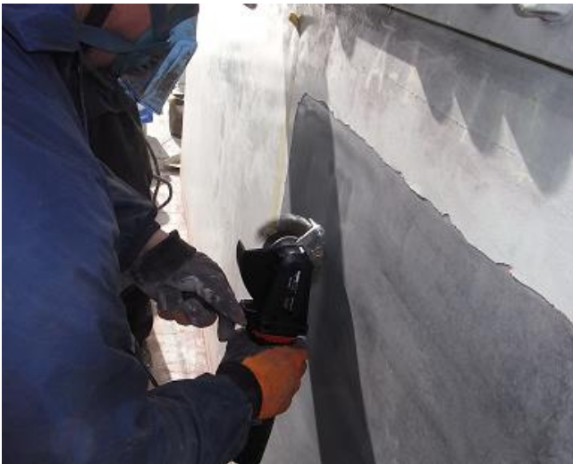
塗膜除去状況
