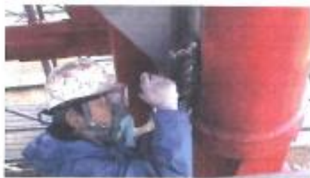
写真-II.4.5 ブラスト面形成動力工具の施工状況
